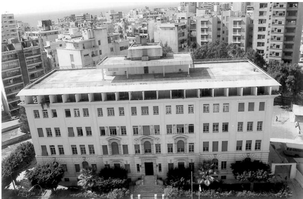
8. Febbraio 1976: foto aerea della facciata nord-est dell'edificio della scuola salesiana dopo la sopraelevazione (ASC – fotografico).
