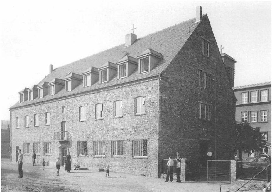
Lehrlingsheim auf den Grundmauern des ehemaligen Jugendheimes 1951. Bergbau Archiv Bochum
