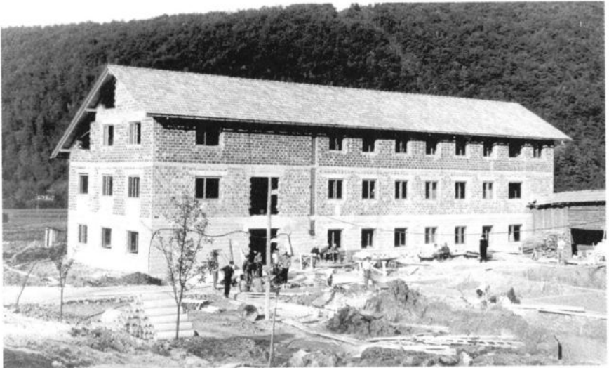
Il collegio salesiano di Želimplje in costruzione.
