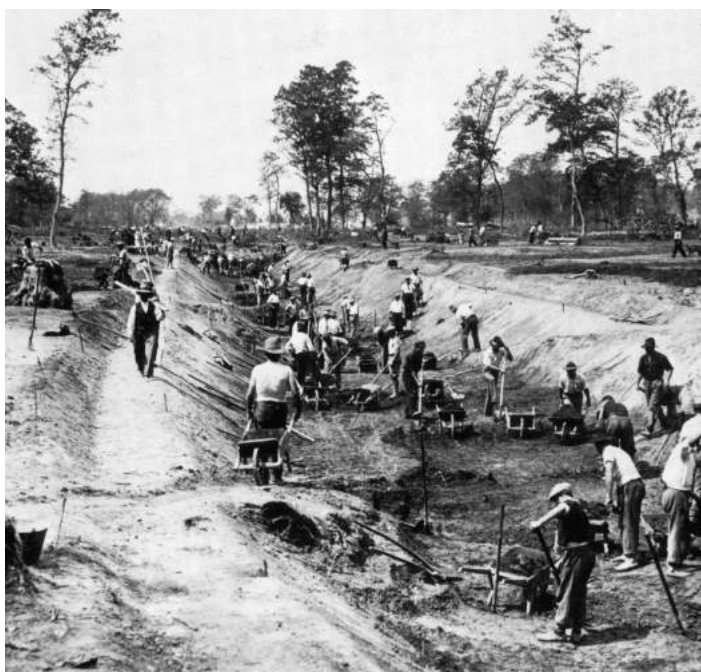
2. Operai impegnati nei lavori di scavo del canale Mussolini
