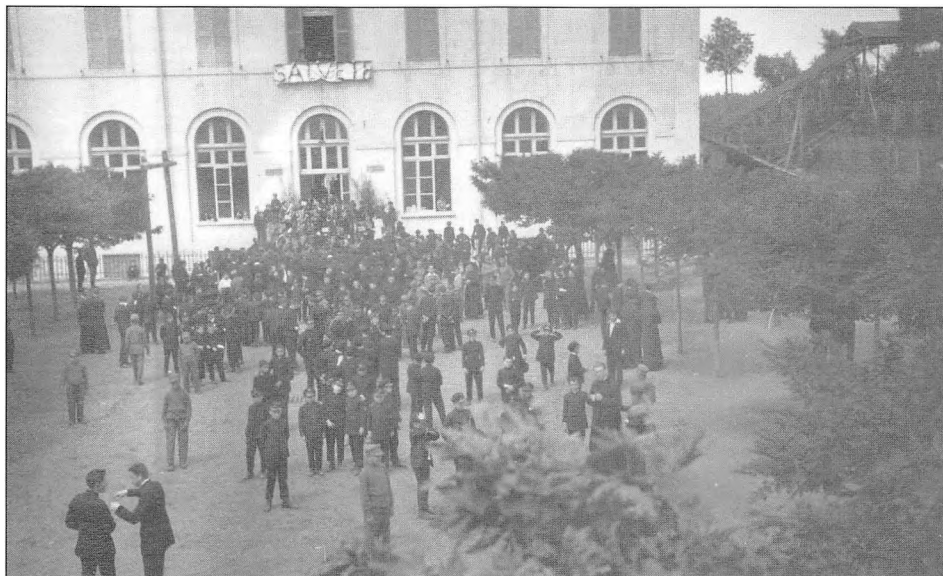
Il cortile e la villa. A destra la scala ed il pergolato che conducevano alla scuola
