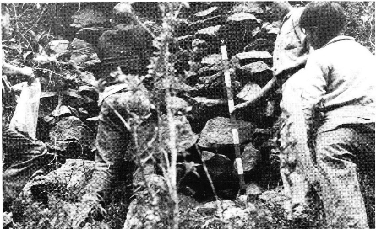
Fig. 11 - Cerro Llaver. Muro de contención hacia el E., con cemento fuerte.
