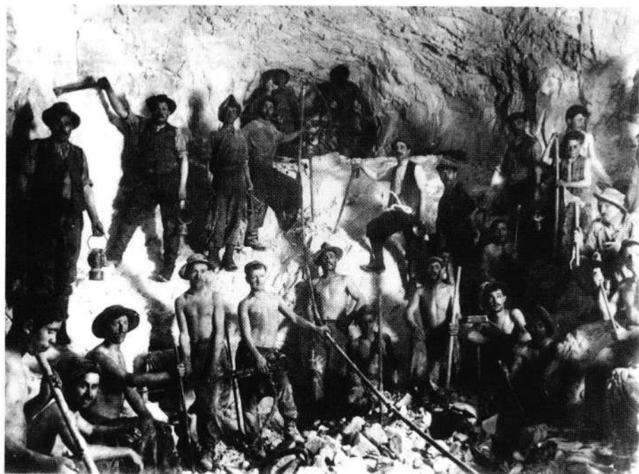
Operai italiani al lavoro all'interno del traforo del Sempione (1910)
