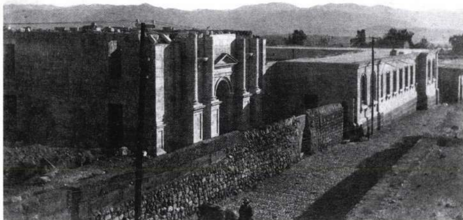
Prédio de Eugênio Cardoso, 1901. Primeira construção dos SDB da Bahia, a que esteve para desabar. Em 19 de dezembro de 1905 começou a reconstrução. A inauguração marcada para 9 de dezembro do ano seguinte, foi adiada por causa das chuvas. Por solicitação do senhor Arcebispo realizou-se aos 16 daquele mês. AFR.
