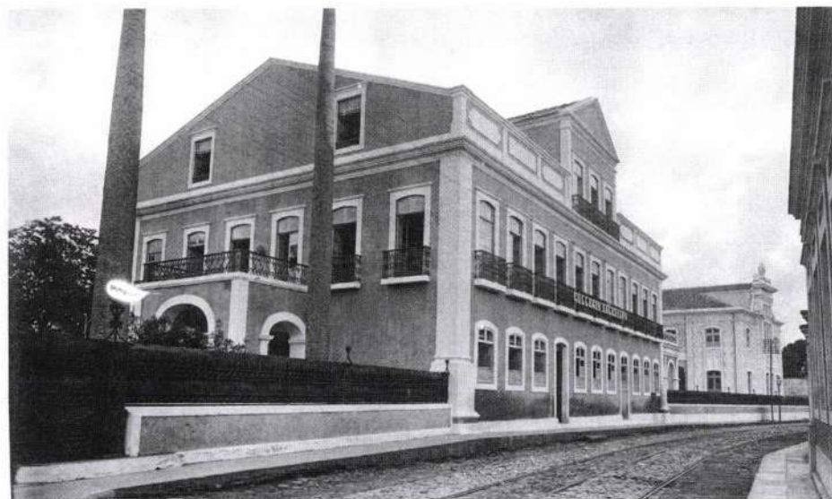
Primeira obra salesiana do Norte do Brasil, inaugurada oficialmente em Pernambuco em 1895. O Dr. Carlos Meneses fala dos trilhos que facilitavam o acesso. A foto é de fevereiro de 1906. O prédio ao fundo é a pensão Almata, demolida no final de 1999. AFR.
